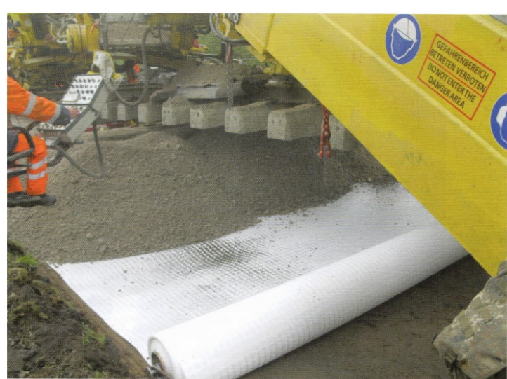
Einbau von Geokunststoffen [3]
